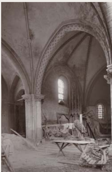
Abbruch eines Teiles der alten Kirche.
